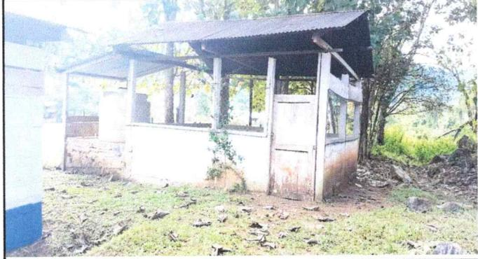
FOTO 2: TECHO Y ESTRUCTURA: LA COCINA NECESITARÁ ESTRUCTURA Y CUBIERTA DE LÁMINA NUEVA.
